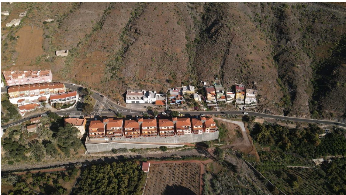
Imagen aérea de la zona sur del ámbito de ordenación, en la que se aprecian muros de contención de grandes alturas. Fuente: Manuel Álvarez (piloto dron).
