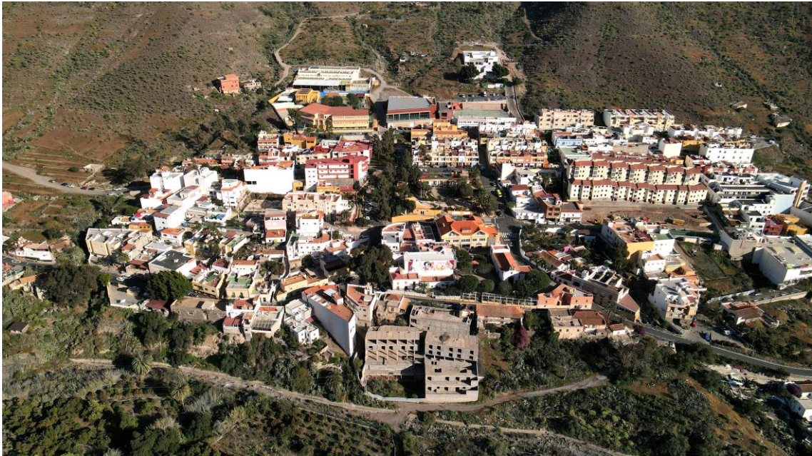
Imagen aérea de la zona norte del ámbito de ordenación, en su contacto con el barranco, en la que se aprecian grandes taludes, medianeras vistas, edificaciones sin terminar de ejecutar, etc. Fuente: Manuel Álvarez (piloto dron).
